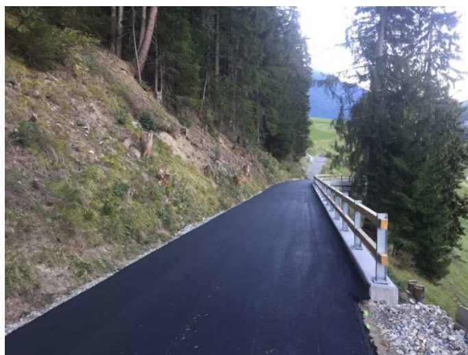
Fertiger Ausbau an gleicher Stelle mit neuem Kordon auf bestehender Mauer und Bänderzaun (Foto: FWBA C. Guetg)
