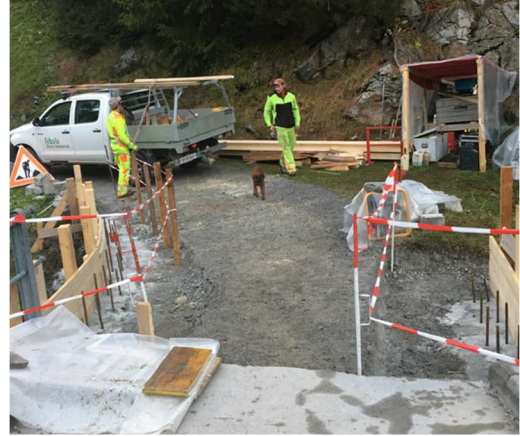
Im Frühjahr 2019 wird das neue Geländer montiert (Fotos: FWBA U. Fliri)
