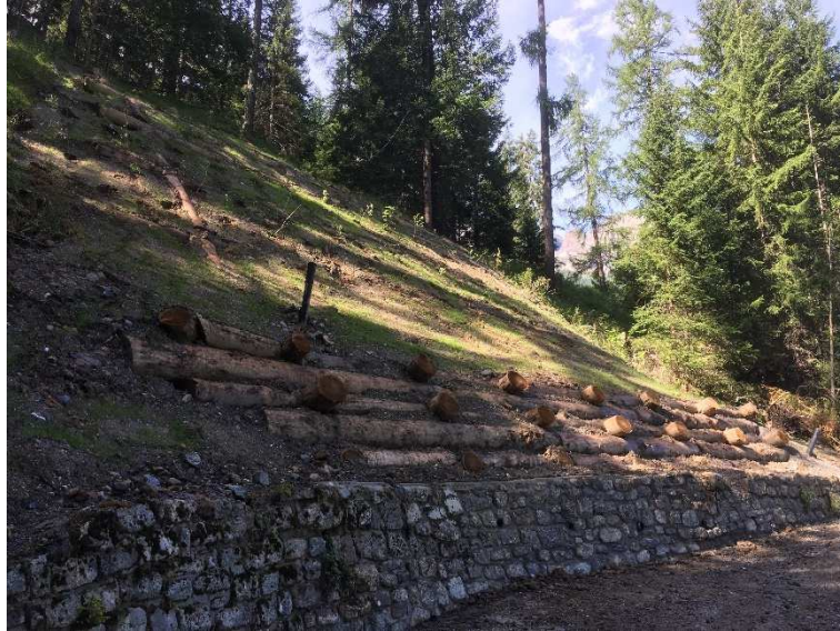
Mit Hangrost gesicherte, bepflanzte und begrünte Böschung (Foto: FWBA U. Fliri)
