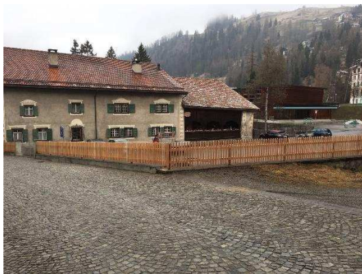
Zaun Parkplatz Schulhaus Bergün (Fotos: I. Castelberg)
