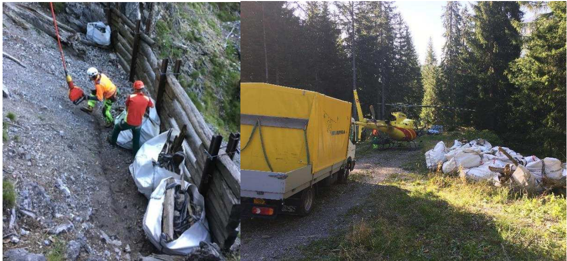
Steine und Holz werden in Big Bags gefüllt und mit dem Helikopter aus den Verbauungen geflogen. SSV Faleinerweg (Fotos: Urs Fliiri)
