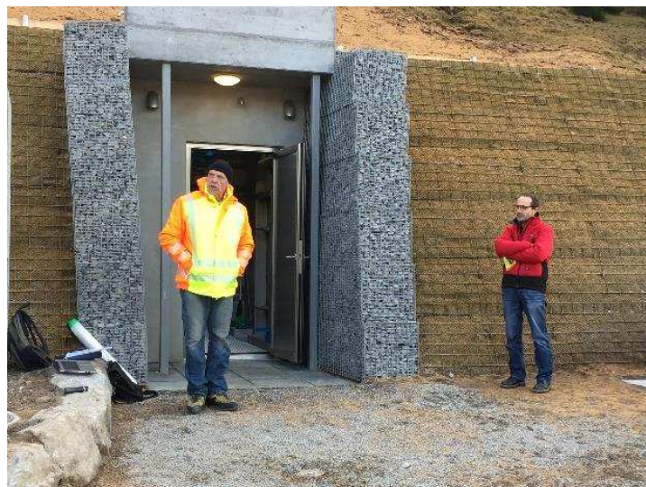
Eingang Reservoir Jenisberg Tag der offenen Tür Foto: I. Castelberg
