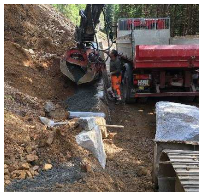
Bau von Blocksteinmauern
