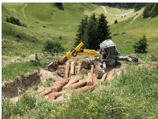
Vorbereitungsarbeiten zur Erstellung des Holzkastens (Fotos: U. Fliri)
