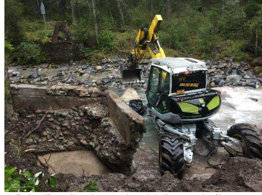
Brücke Ziegelboden: Instandstellungsarbeiten
