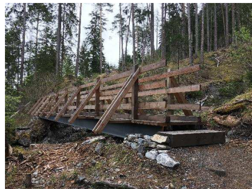
Wanderwegbrücke Talwanderweg Surava - Tiefencastel
