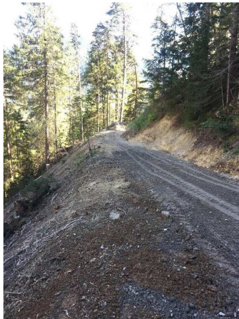
Mit Holzkasten gesichert und eingedeckt
