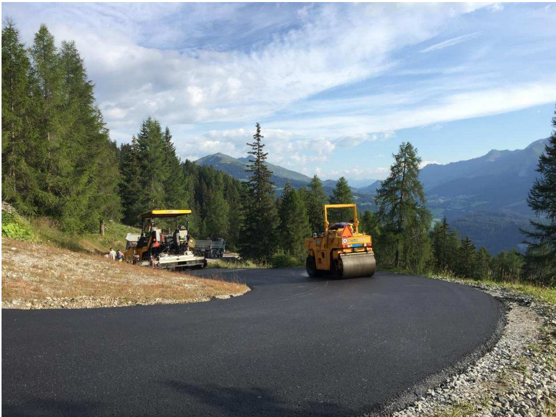
Während dem Belageinbau (Foto: C. Guetg)
